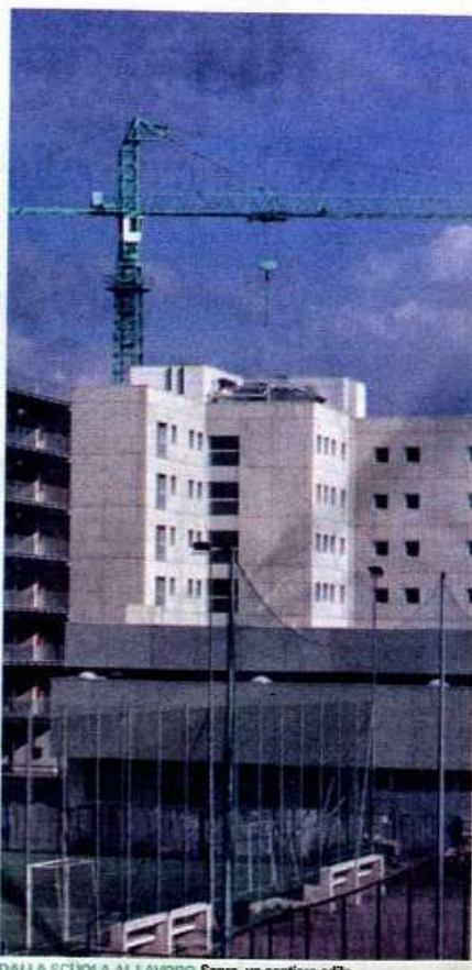
DALLA SCUOLA AL LAVORO Sopra, un cantiere edile
